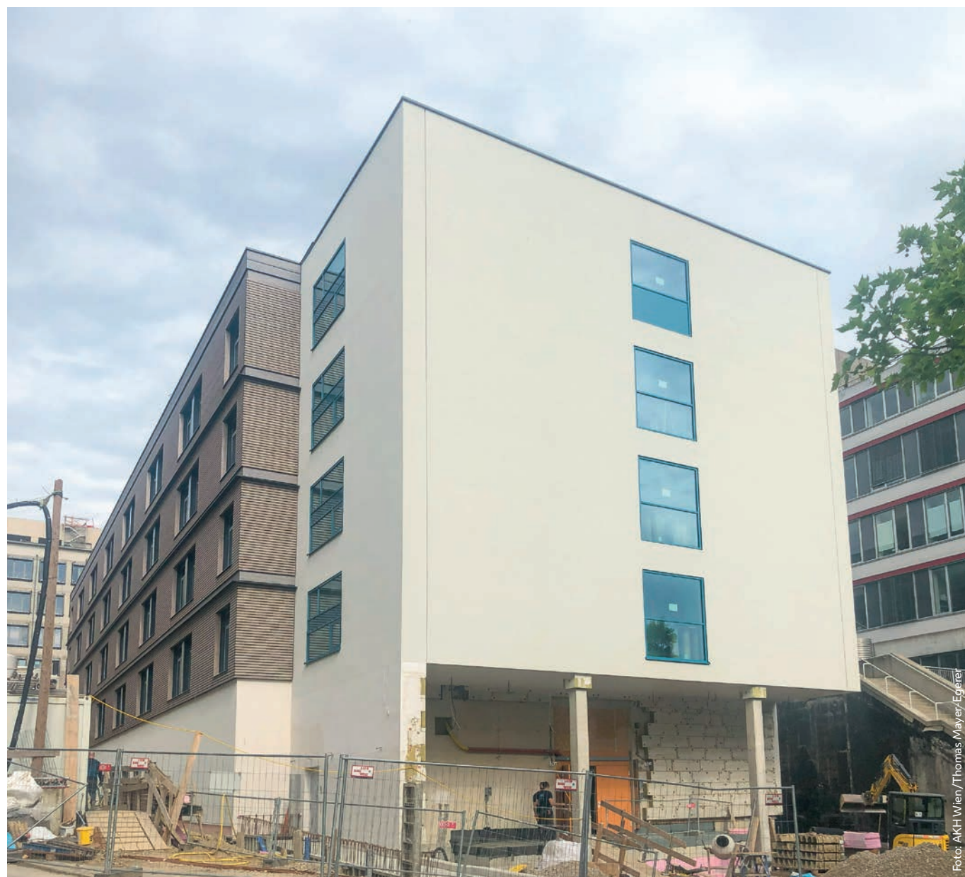
Das Stationsgebäude Süd wurde großteils in Holzmodulbauweise errichtet.
